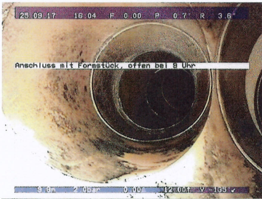
124'02_124'03_4324016e-0a0e-4de0-9bc2-79af86f0e928_20170925_160422_562.jpg, 00:02:44, 9.89 Anschluss mit Formstück, offen bei 9 Uhr
