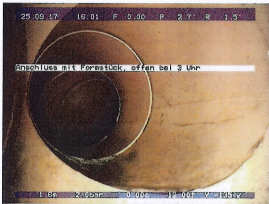
124'02_124'03_fa691d3b-9409-43a2-8ba9-6ef6578d43b6_20170925_160136_987.jpg, 00:00:18, 1.63 Anschluss mit Formstück, offen bei 3 Uhr
