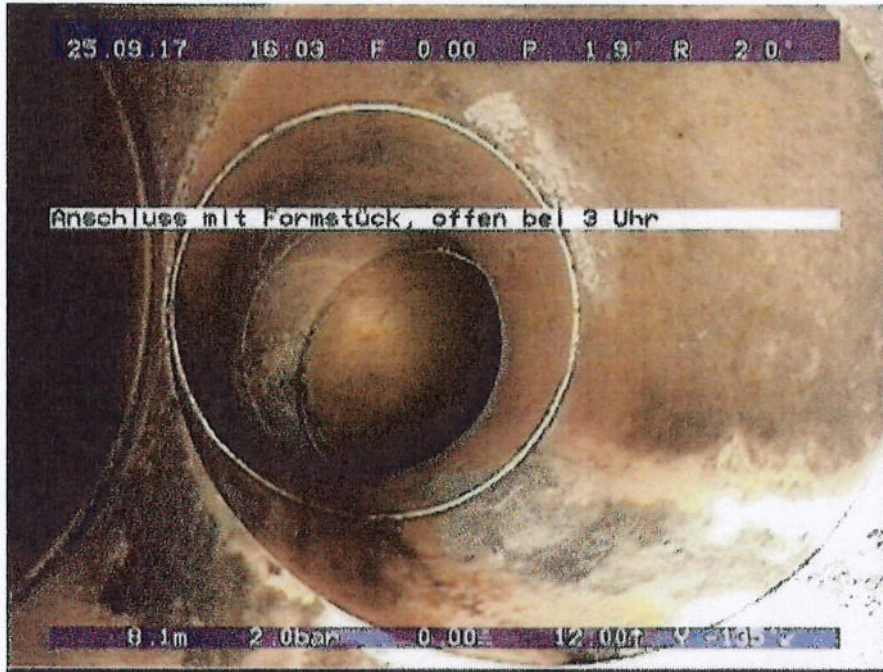
124'02_124'03_dcd82770-f2c2-49d5-942e-3f2194fb1f8d_20170925_160324_692.jpg, 00:01:56, 8.17 Anschluss mit Formstück, offen bei 3 Uhr
