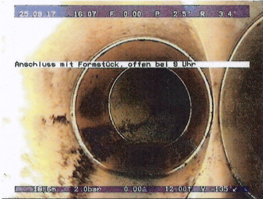
124'02_124'03_2a15322f-3a27-4c6e-92bd-df7148fc004a_20170925_160806_039.jpg, 00:05:23, 18.69 Anschluss mit Formstück, offen bei 9 Uhr
