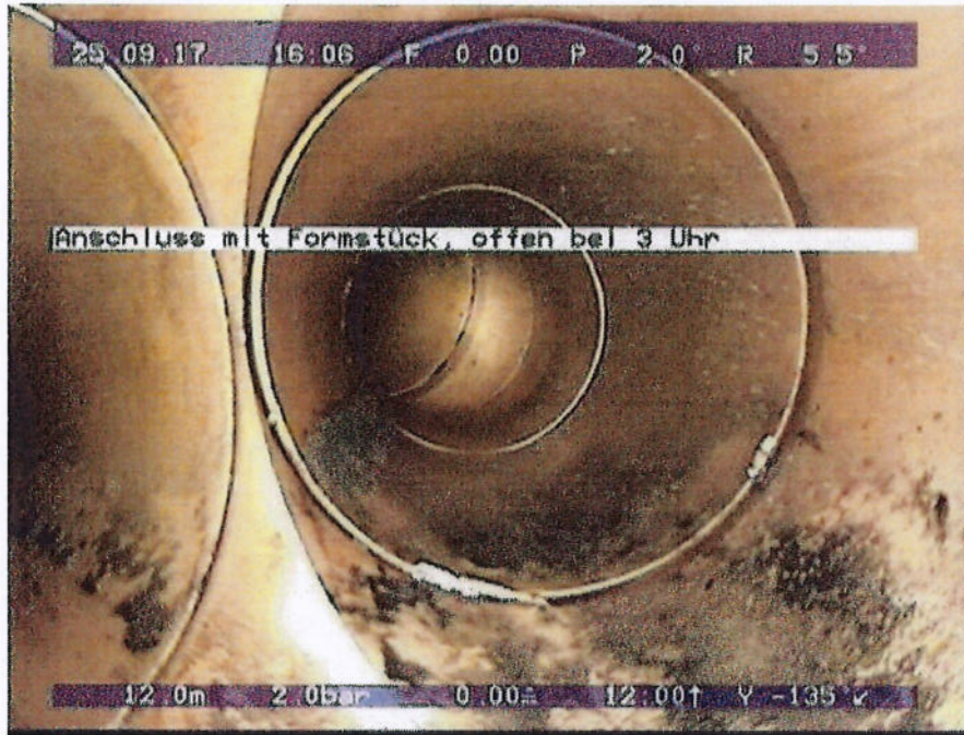
124'02_124'03_9b213686-f21c-4ffc-913a-02d615a7eac6_20170925_160628_671.jpg, 00:04:04, 12.05 Anschluss mit Formstück, offen bei 3 Uhr
